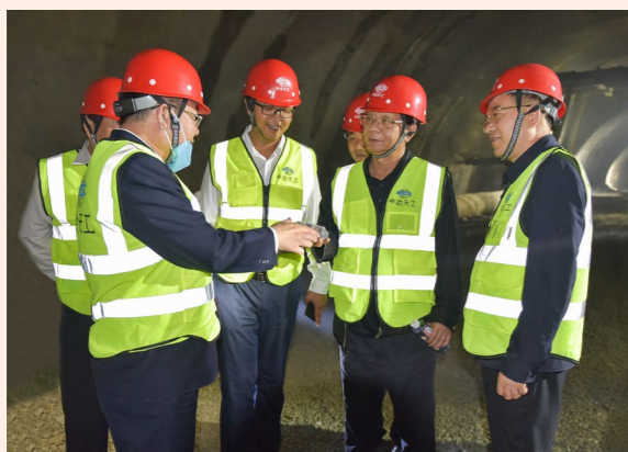
高速公路项目安全专项检查
