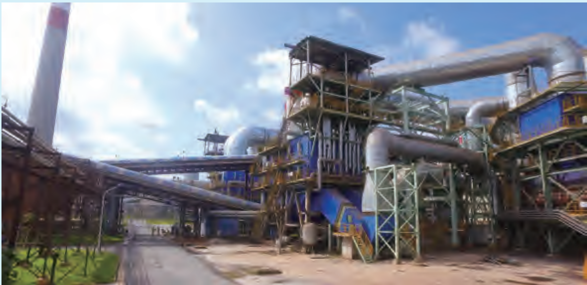
宝钢湛江钢铁基地烧结余热发电工程
