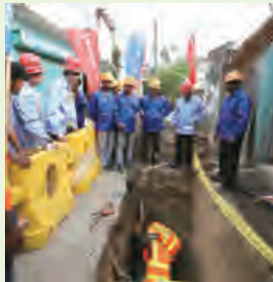
地下管网供水项目施工现场
