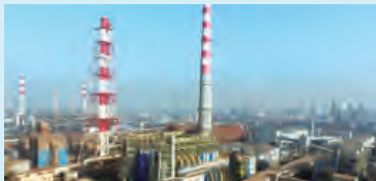
宝钢炼铁厂三烧结大修改造工程烟气净化工程
