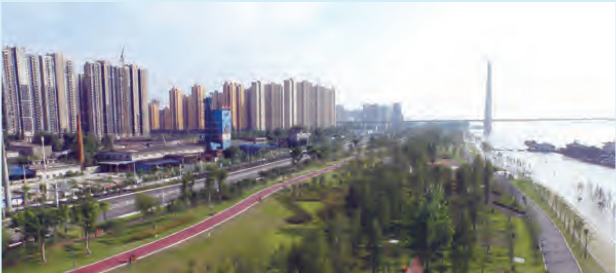
武汉市武青堤江滩综合改造工程
