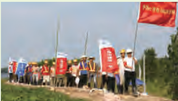
通顺河固堤抢险
